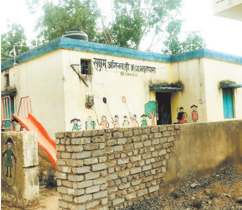
पुराने लेआउट से बना आंगनबाड़ी भवन।
